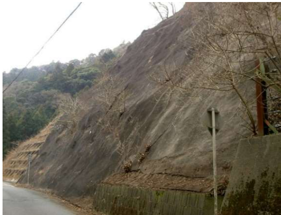
モルタル・コンクリートで吹付けられた法面（例）
