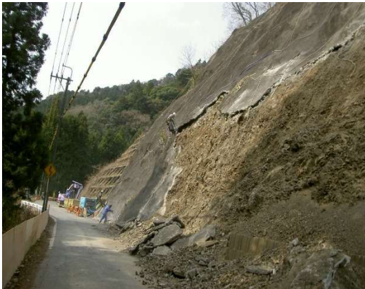
人力による取壊し状況
