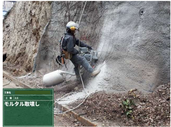
カッター切断による施工
