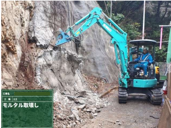
機械施工による取壊し
