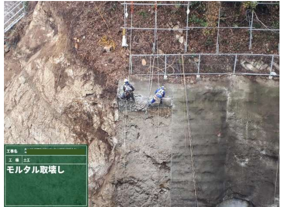
人力による取壊し
