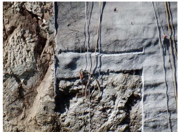
カッター切断による施工
