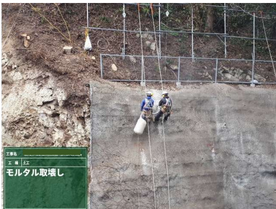
カッター切断による施工
