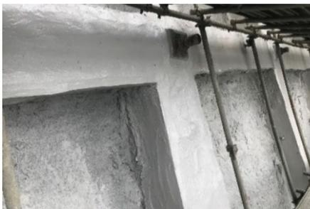
写真7 表面被覆工の施工
